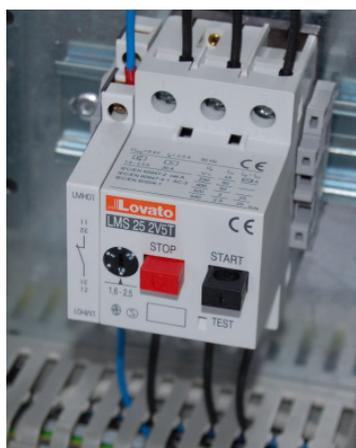
Прежде, чем снова включить предохранитель (путём нажатия кнопки “СТАРТ“), убедитесь в том, что биметалл (датчик) остыл.
